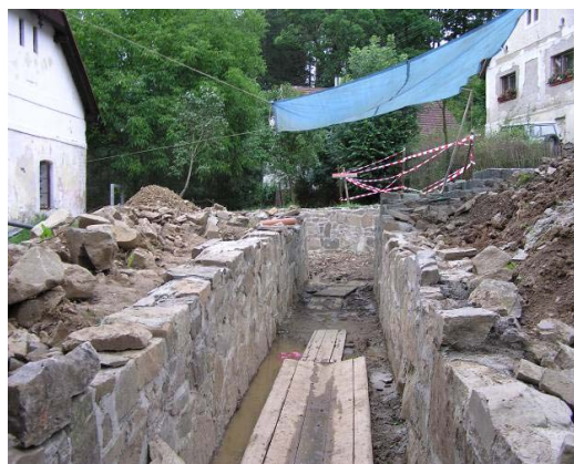
Obrázek č. 9 – Téměř hotová oprava
