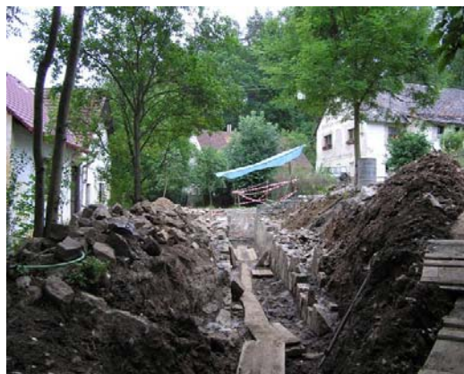
Obrázek č. 7 – Zpevňování břehů koryta
