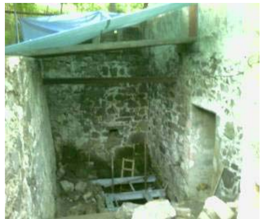
Obrázek č. 4 – Probíhající rekonstrukce lože turbíny ve strojovně
