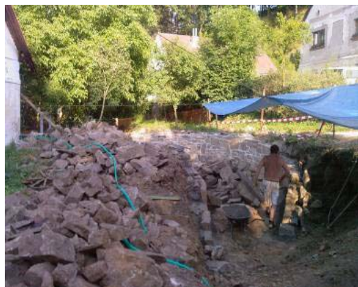
Obrázek č. 8 – Fáze obnovy předlohové nádrže před vantroky
