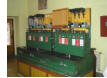
Obr.: Ve starších dopravních kancelářích je možné ještě vidět řídicí přístroj elektromechanického staničního zabezpečovacího zařízení, který zabraňuje bez vědomí výpravčího přestavění jízdní cesty vlaku a kontroluje práci signalistů na stavědle. (ilustrace Jiří Bouda)
