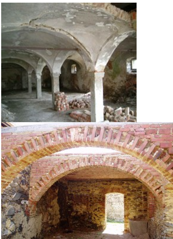
Obrázek č. 15 - Již statisticky zabezpečená budova (rok 2009) 56
