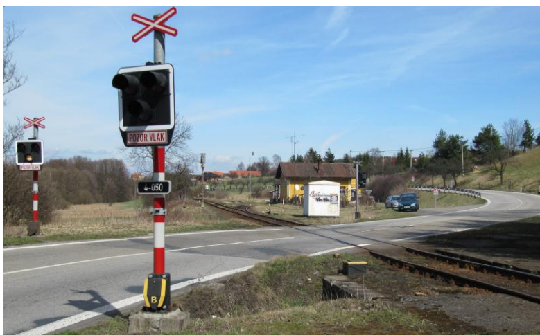
Příloha č. 19 Železniční přejezd ve Strunkovicích nad Volyňkou.
