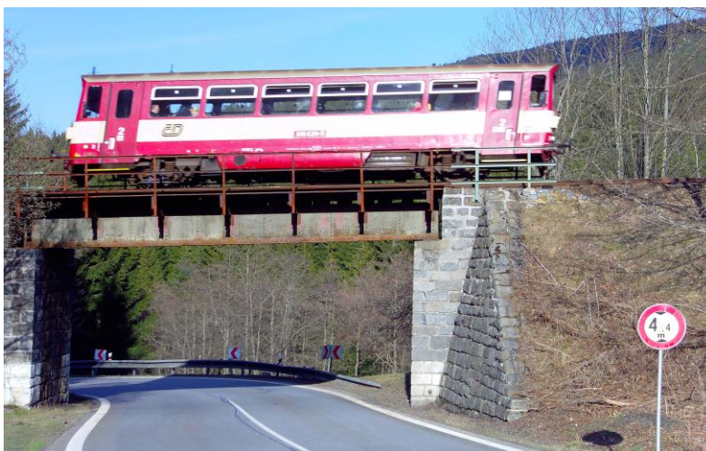
Příloha č. 41 Železniční nadjezd poblíž Kubovi Hutě.
