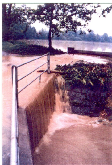
Přetékání hráze Hliněného rybníka v místě výpusti.
