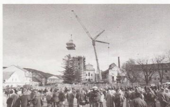
Oprava farního kostela za dotace se podařila
