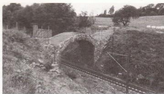
Současný stav Nazdického mostu
