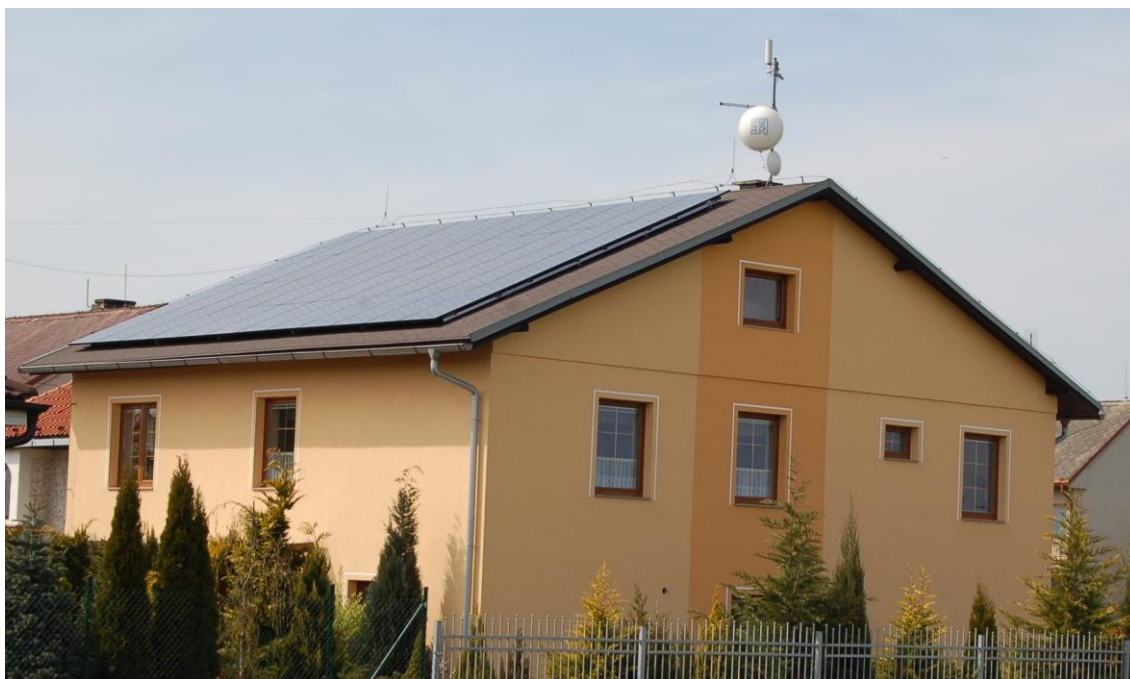
Zdroj: vlastní foto – FVE na rodinném domu manželů Novotných, Dasný
