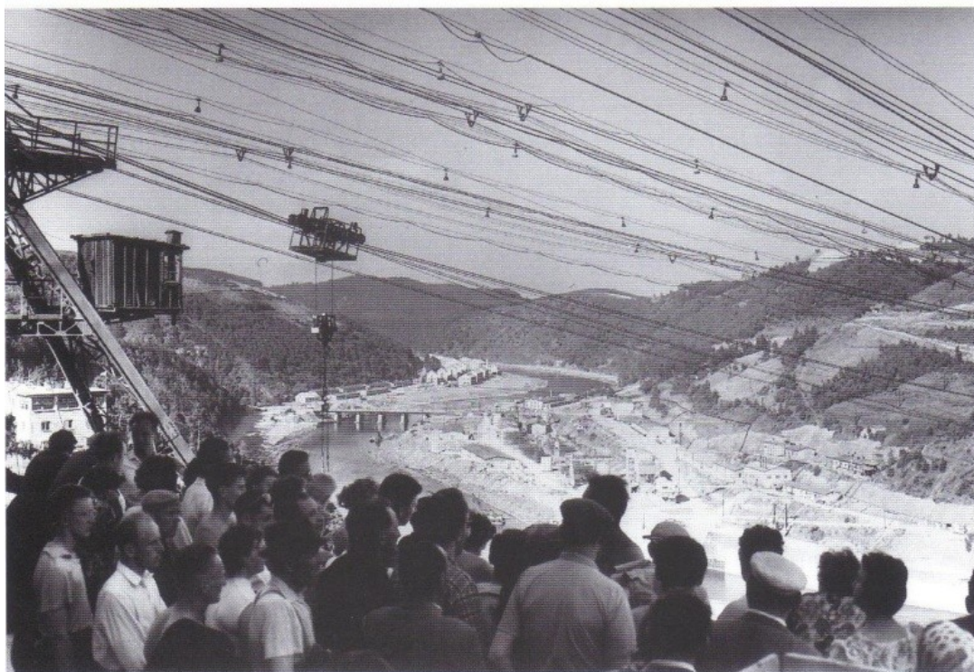
Obr. 22 12. července 1959 – Den stavbařů 144
