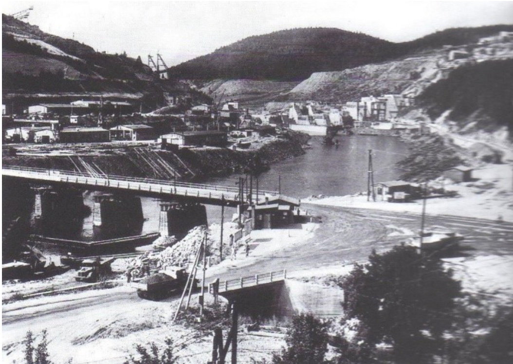
Obr. 20 Dva zavádilské mosty, v levé části je technické zázemí stavby 142
