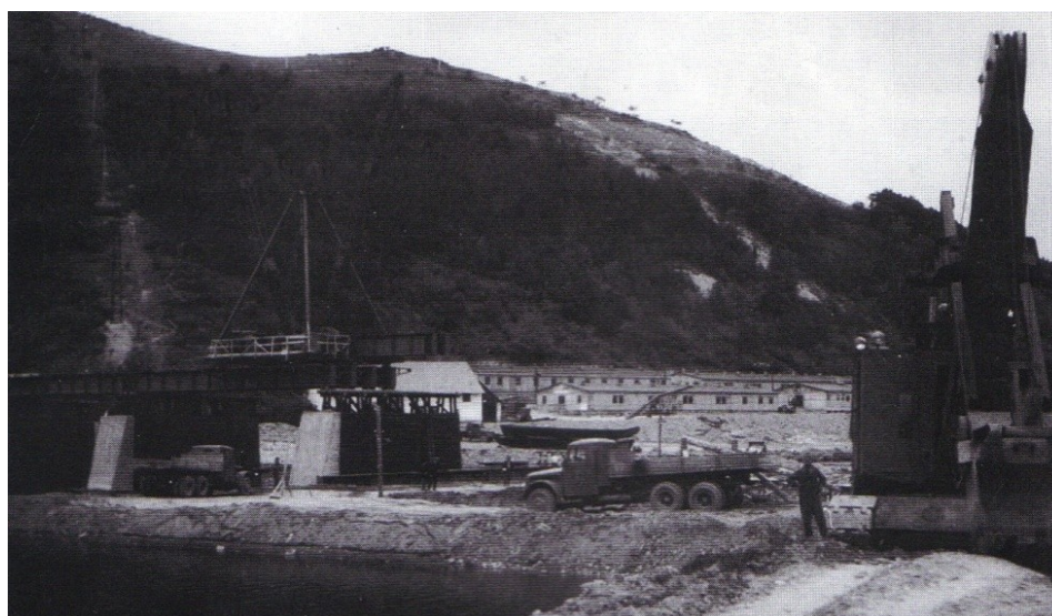
Obrázek 7 Stavba mostu v Solenicích, rok 1955 82
