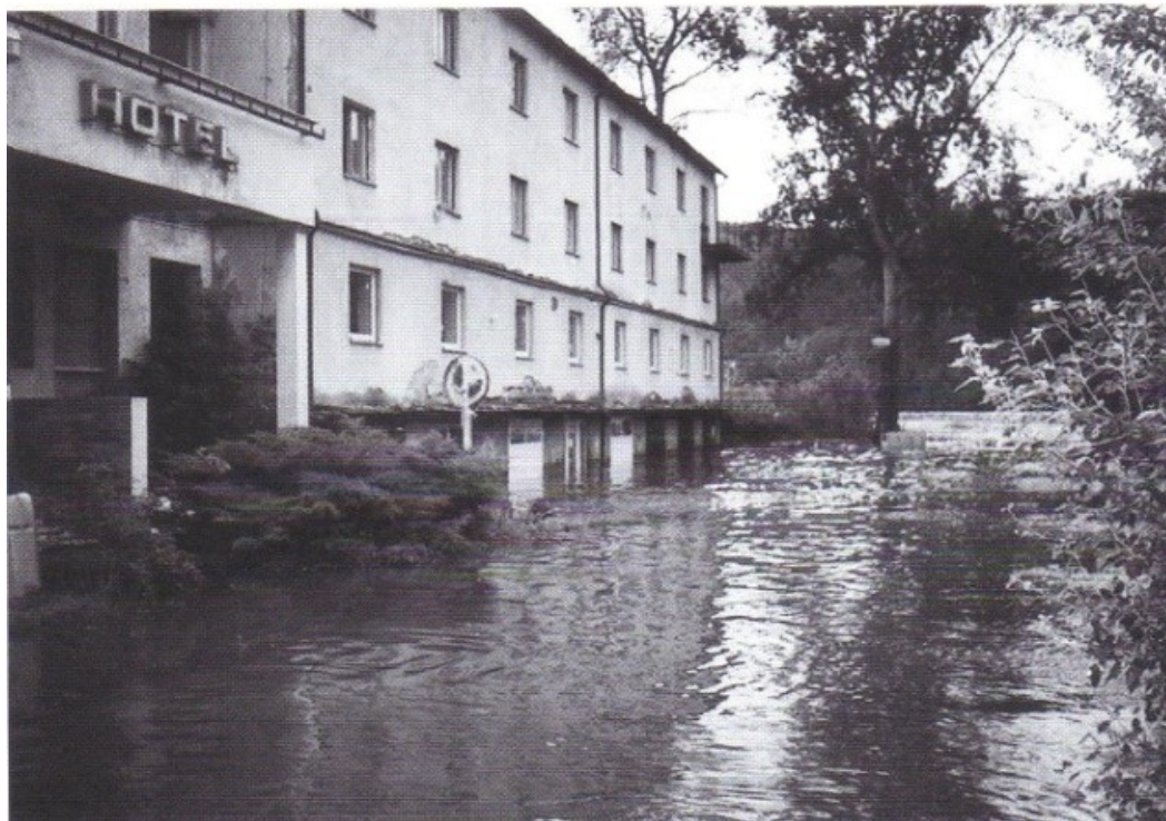
Obr. 24 Zatopený hotel v Solenicích 146
