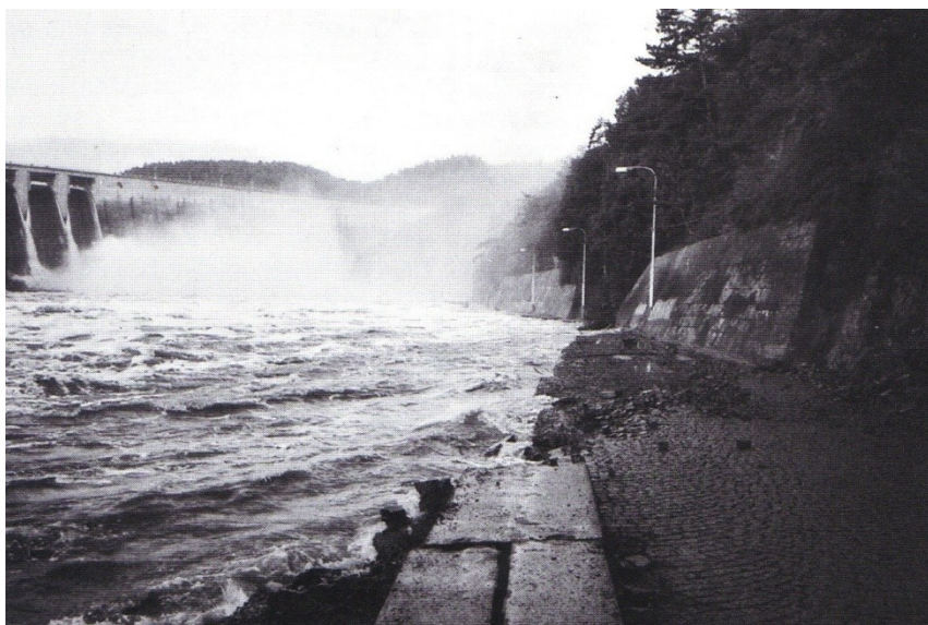
Obrázek 11 Přehrada Orlík při povodních a zcela zatopená přístupová komunikace 118
