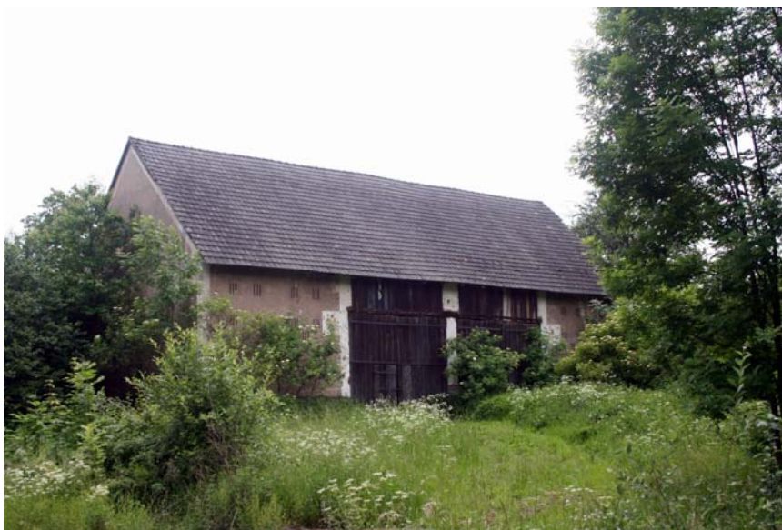
Jediné zachovalé stavení v zaniklé obci Hrachoviště
