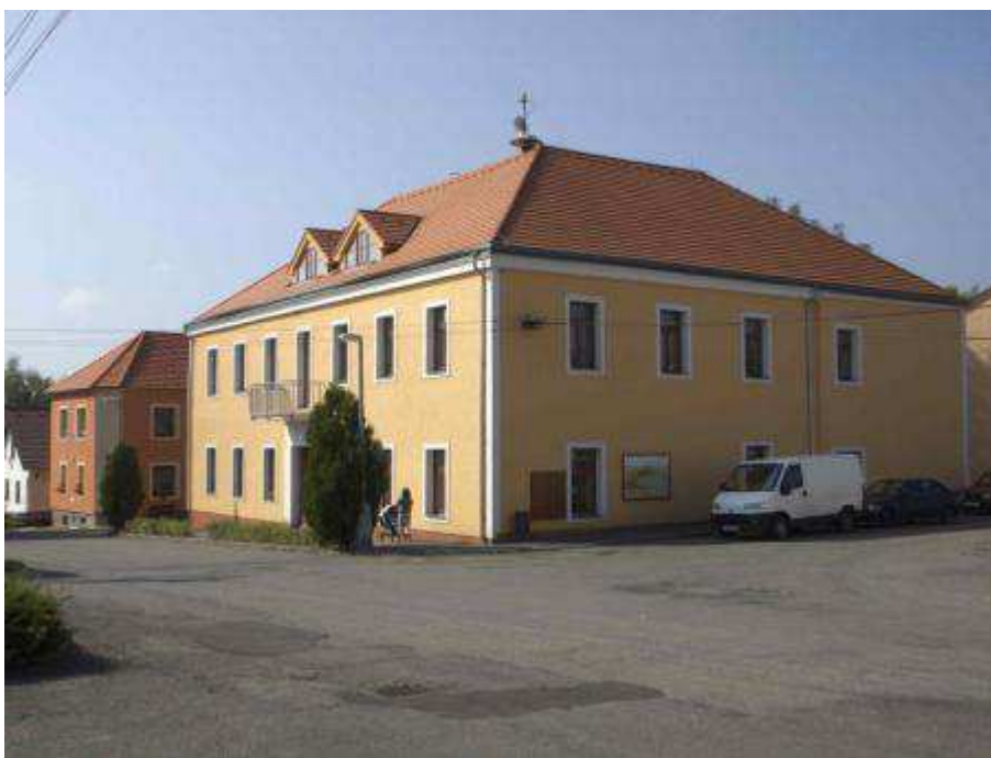
Obr. 3: Základní škola v obci Věšín 109
