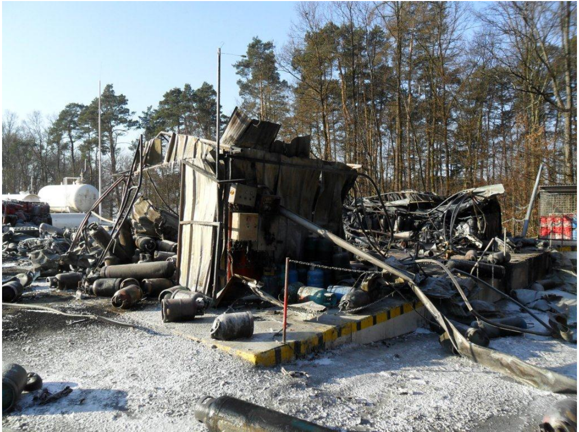
Pohled na zničenou budovu plnění plynu
