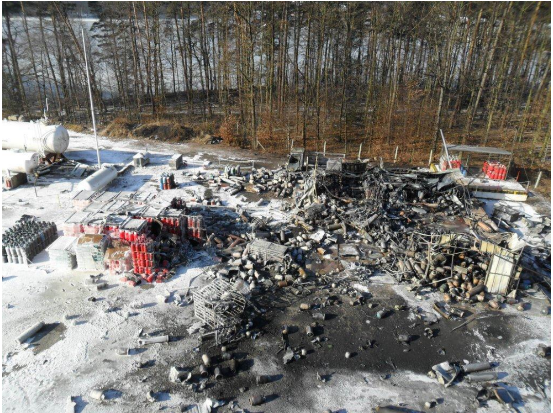
Letecký pohled na místo požáru
