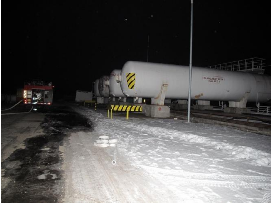
Pohled na nadzemní stacionární nádrže
