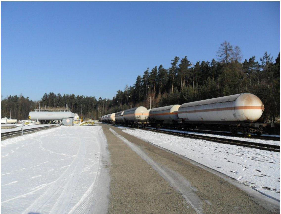
Pohled na část objektu, která nebyla zasažena požárem
