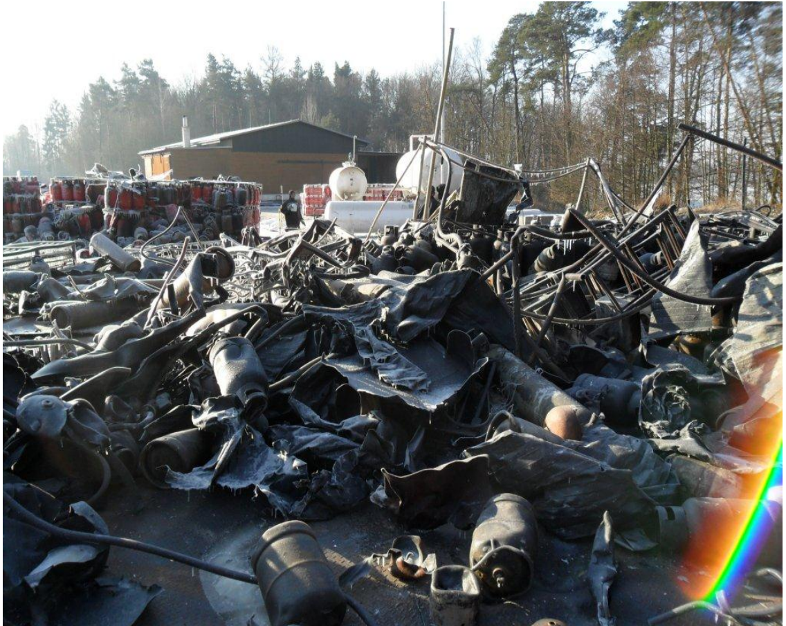
Uskladněné plynové lahve poničené vlivem požáru
