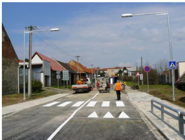
Obr. č. 11: dlouhý zpomalovací práh integrovaný s přechodem pro chodce 40
