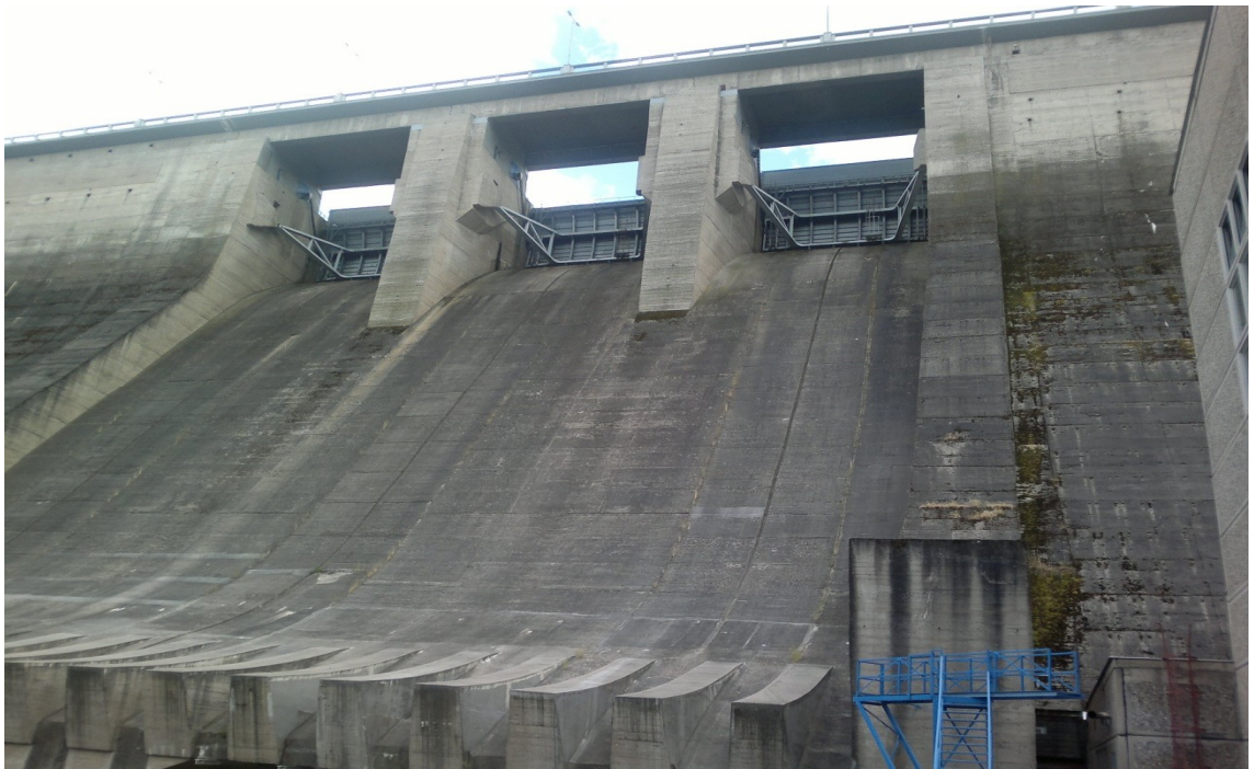
Obr. č. 1: Pohled na přelivy z místa vodní elektrárny.
