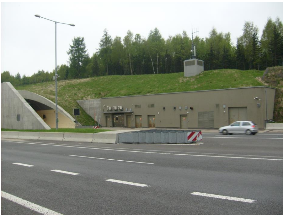
Provozní velín operátora dopravy a operátora technologie tunel Panenská - Sever.
