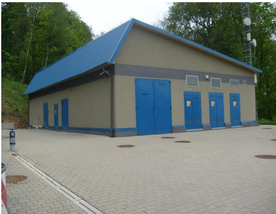
Provozní velín operátora dopravy a operátora technologie tunel Liboucheč – Jih.
