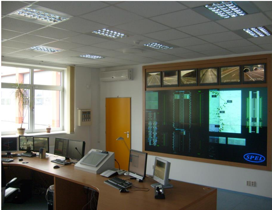
Dispečerské pracoviště operátorů řízení dopravy dálničního oddělení Policie ČR. Řehlovice.
