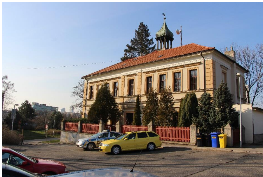
Obr. 4: Budova Policie ČR, MOP Strašnice v ul. V Zátočce 1 40
