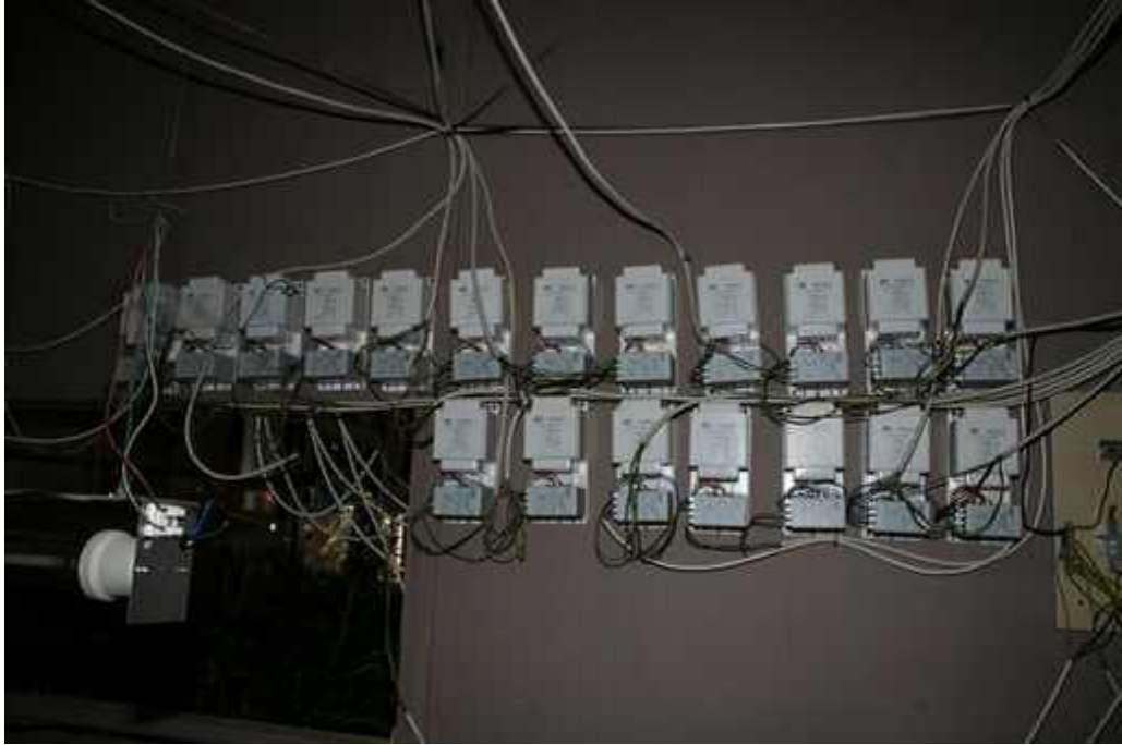
Předřadníky pro vybuzení halogenových výbojek k osvětlení rostlin.
