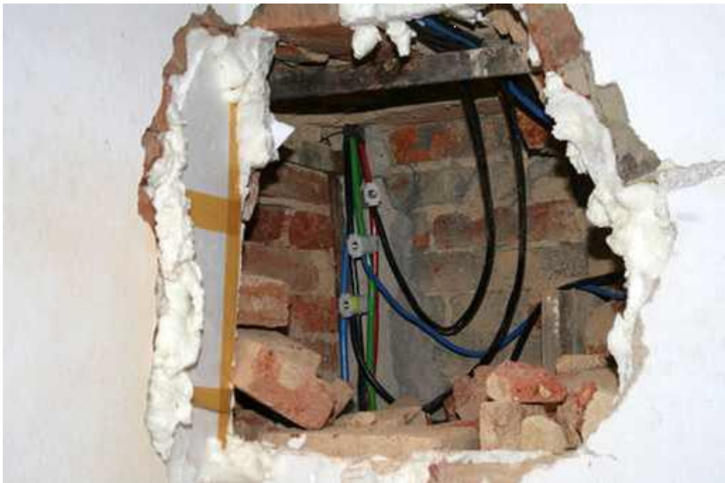
Nelegální, tzv. černý odběr elektřiny pro pěstírnu.
