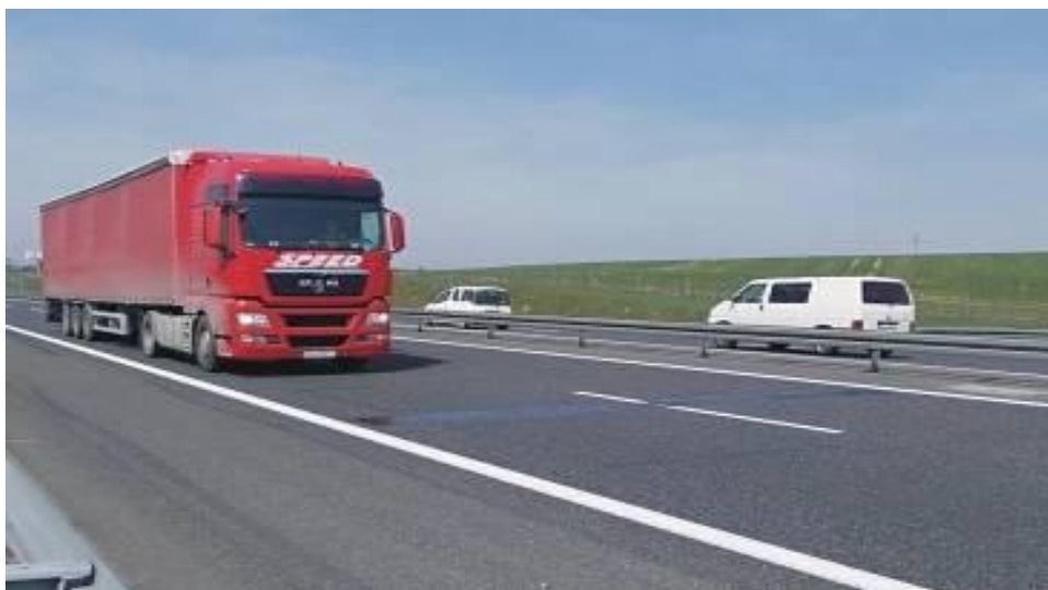
Obr. 5: Vysokorychlostní váha integrovaná do vozovky 23
