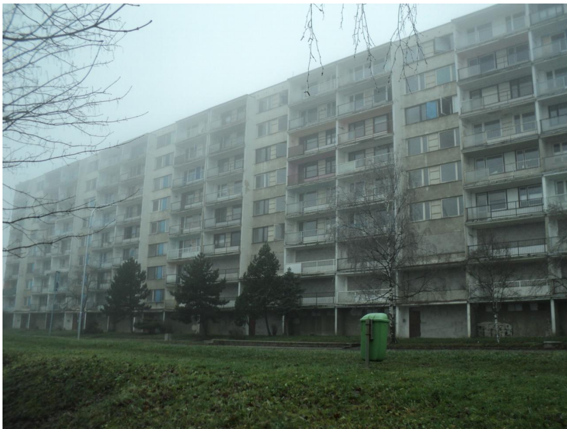
Panelový dům na janovském sídlišti v ulici Hamerská
