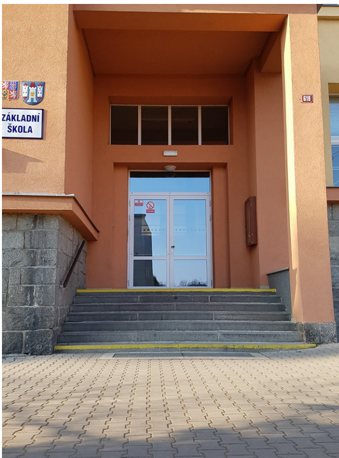
Nezabezpečený vchod do budovy ZŠ Dobřany
