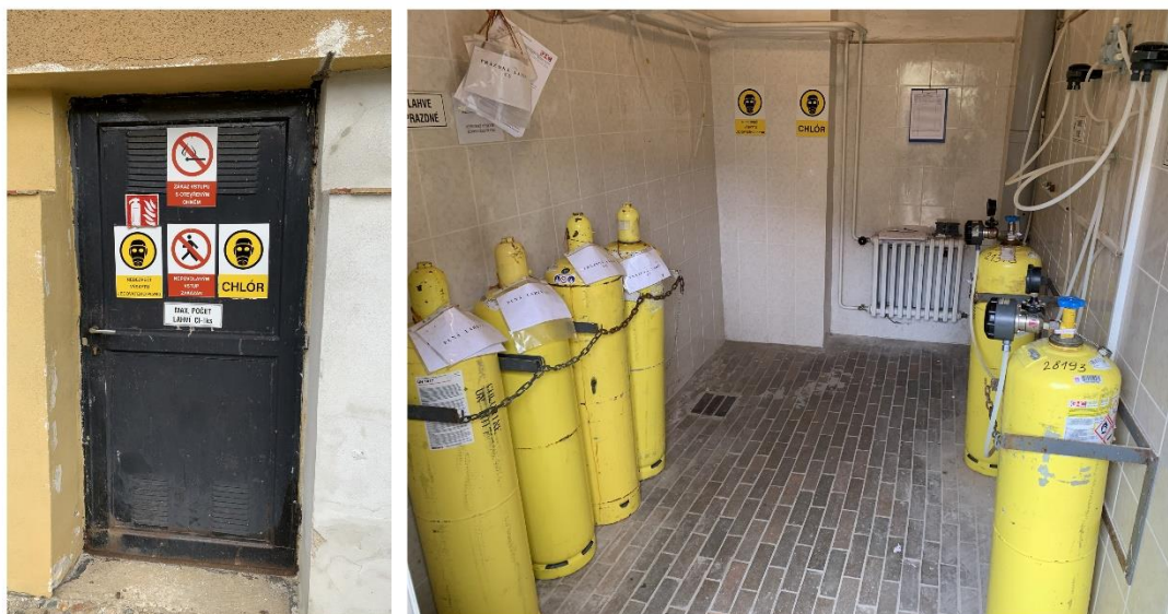
Obrázek č. 1 – vstup do chlorovny a prostor chlorovny 25
