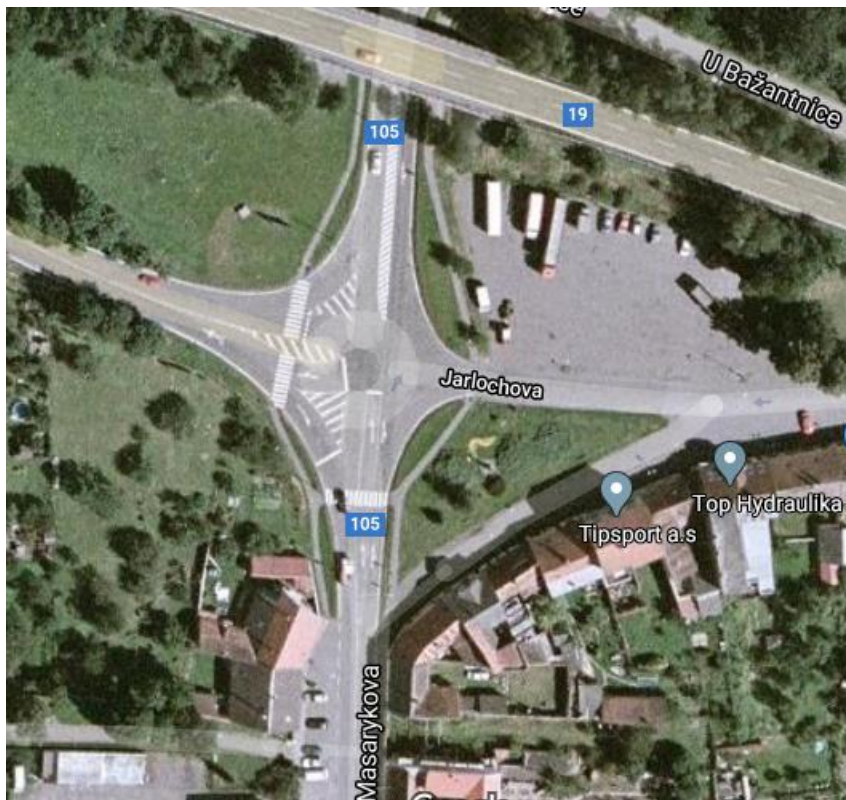
Obrázek 13 – Původní stav křižovatky „U Viaduktu“ 133
