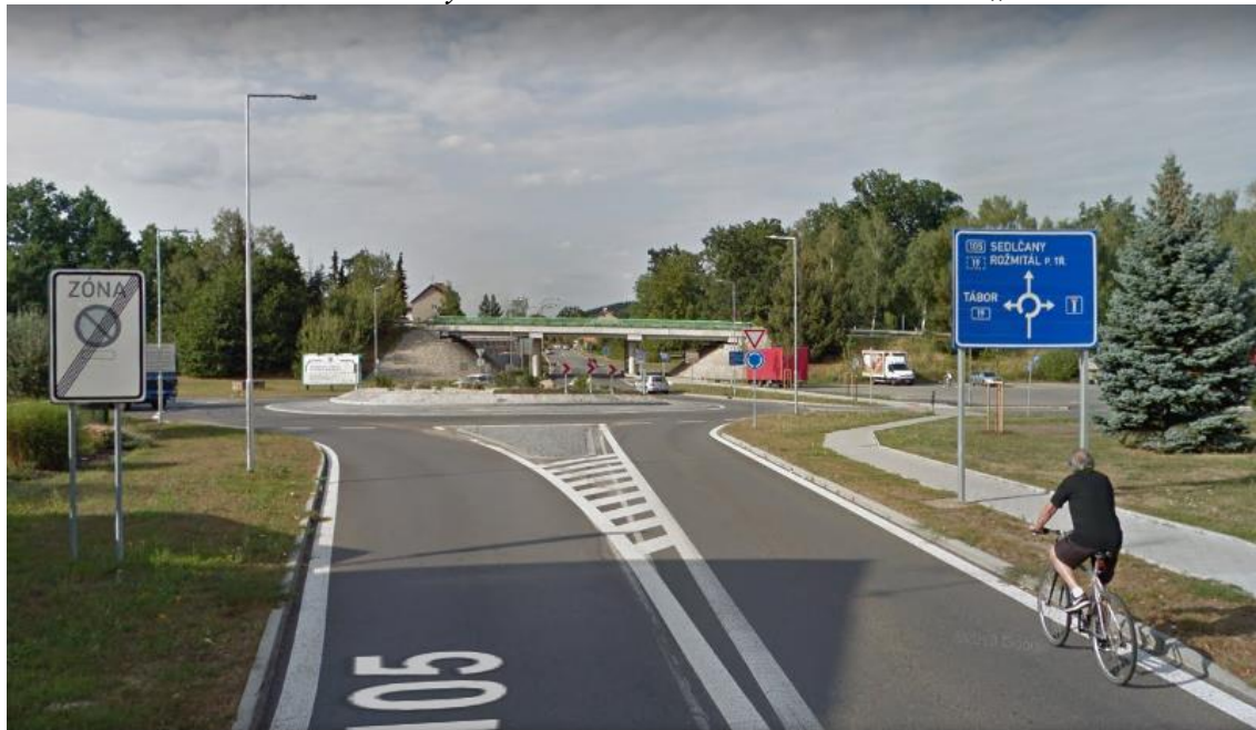
Obrázek 14 – Nově vybudovaná okružní křižovatka „U Viaduktu“ 134
