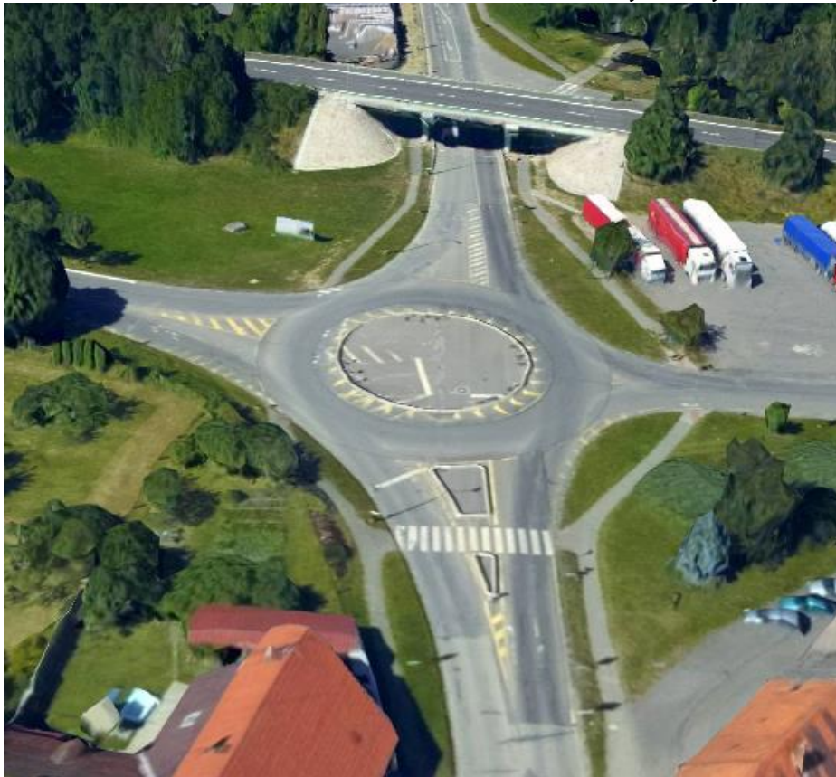
Obrázek 12 – Provizorní okružní křižovatka z betonových City bloků 132
