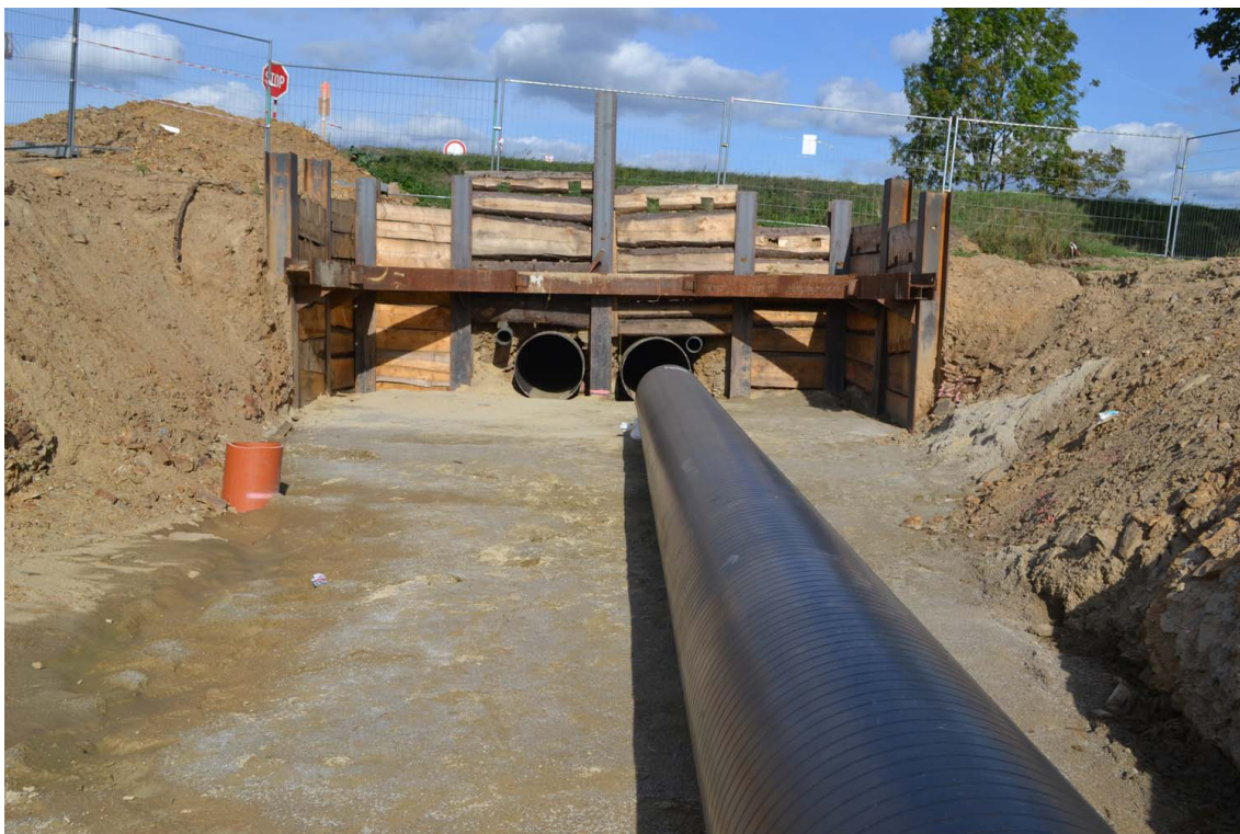
Obrázek č. 9 – Realizace protlaku 61
