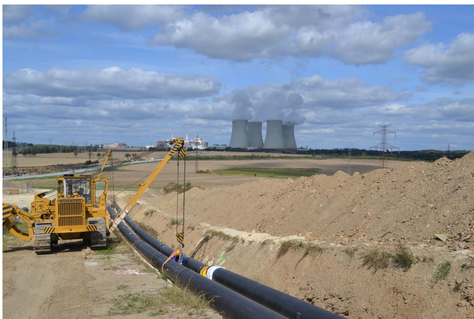
Obrázek č. 1 – Dvoutrubkový horkovod 43
