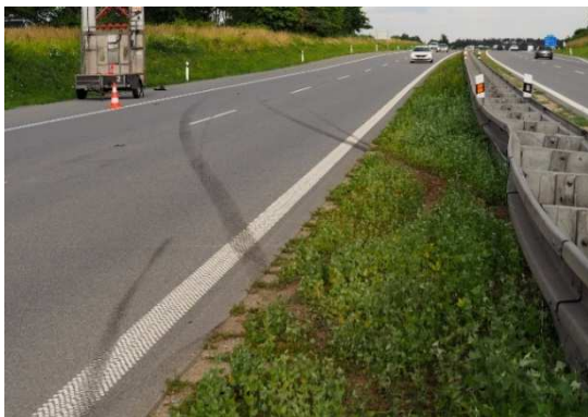
Obr. 7: Smykové stopy na vozovce 54
