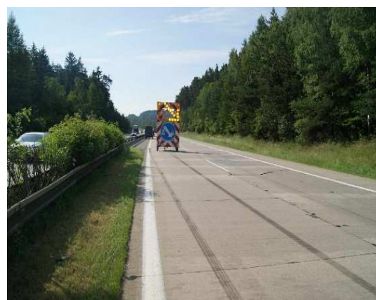
Obr. 5: Blokovací stopy nákladního vozidla 52 Obr. 6: Blokovací stopy osobního vozidla 53
