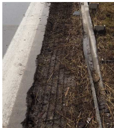
Obr. 3: Stopa jízdy nákladního vozidla na měkkém povrchu 50
