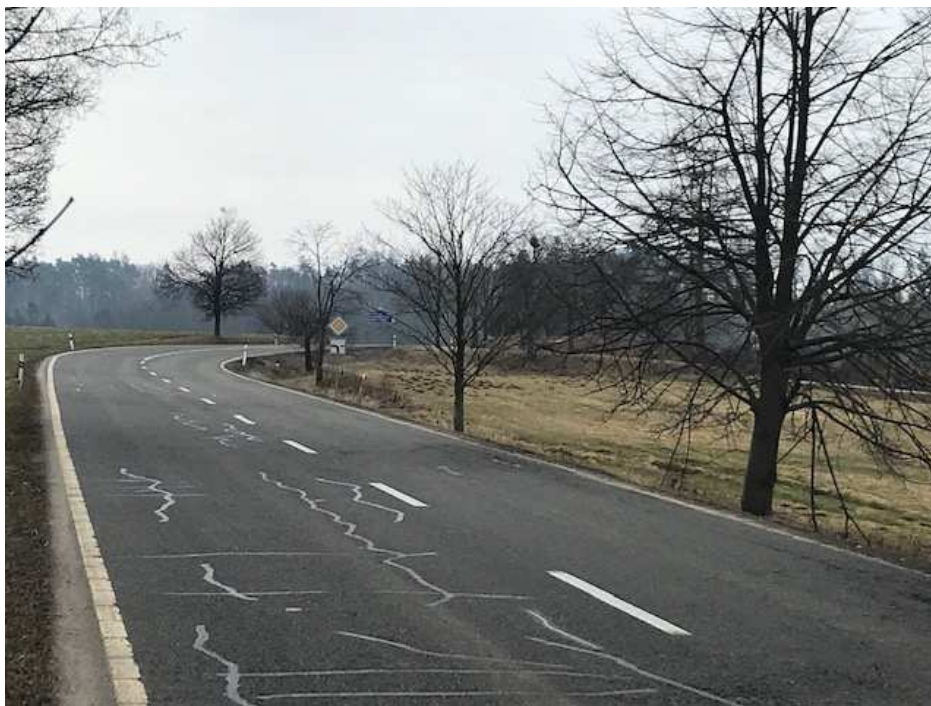
Obr.7: Fotografie z přímého pozorování nehodového úseku č.2 40
