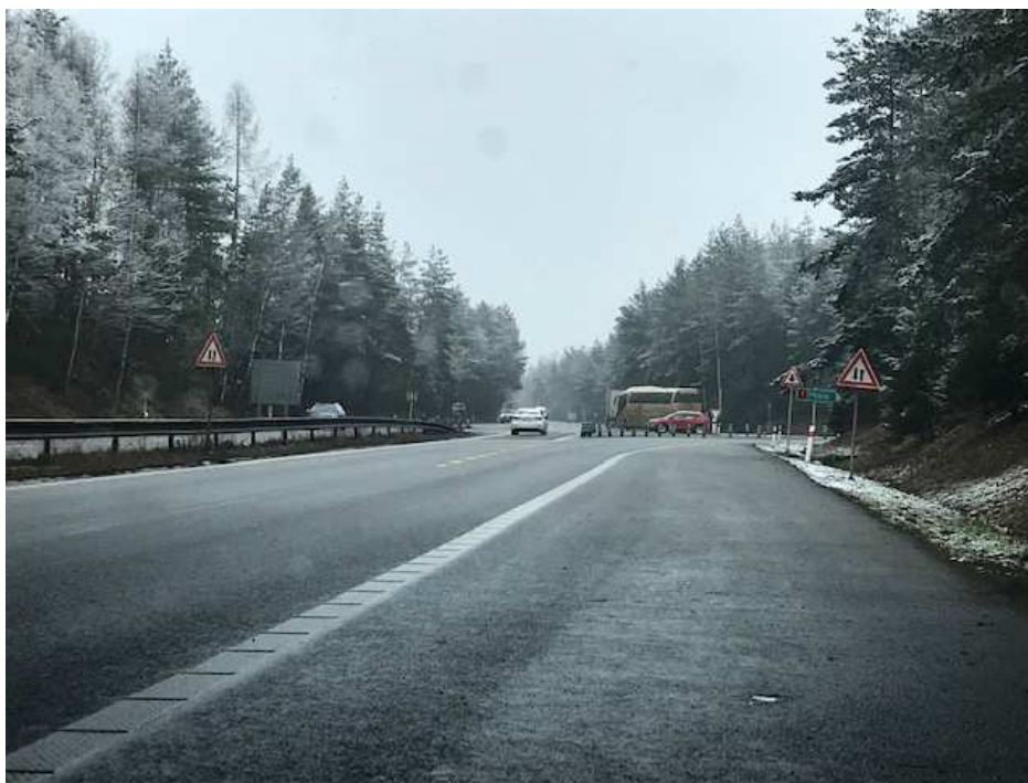
Obr. 6: Fotografie z přímého pozorování nehodového úseku č.1 37
