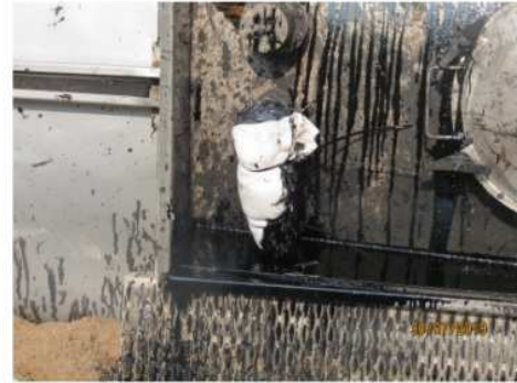
14. detail úniku asfaltu z cisterny
