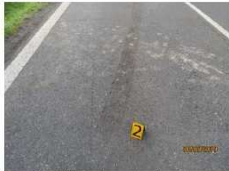
7. pohled na stopy na poz. komunikaci
