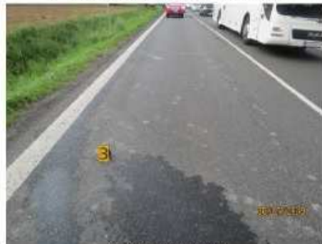
9. stopy na vozovce
