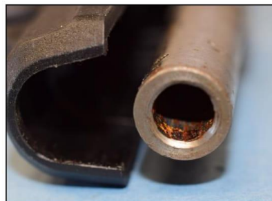
Foto č. 4 – koroze vývrtu
