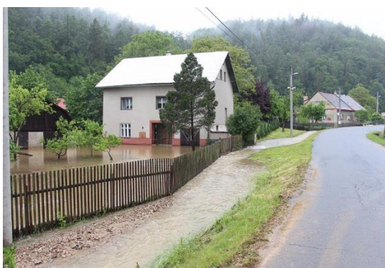
Obr. č. 12: Zaplavené domy 55
