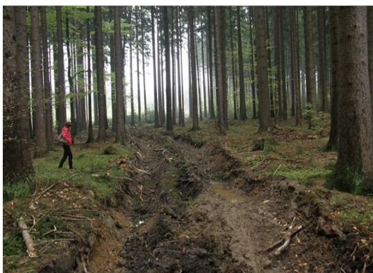
Obr. č. 3: Poškozená lesní cesta 30
