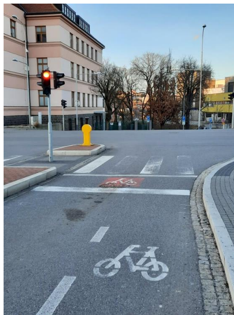
Obr. 14 Vyhrazený prostor před světelným signalizačním zařízením na ulici Nádražní v Třebíči. 100
