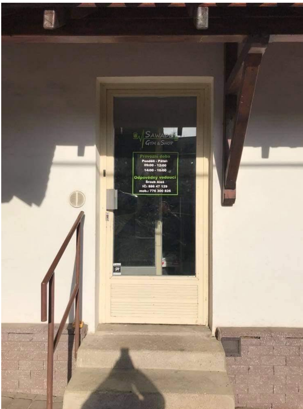
Obrázek č. 3 – Vchod do objektu
