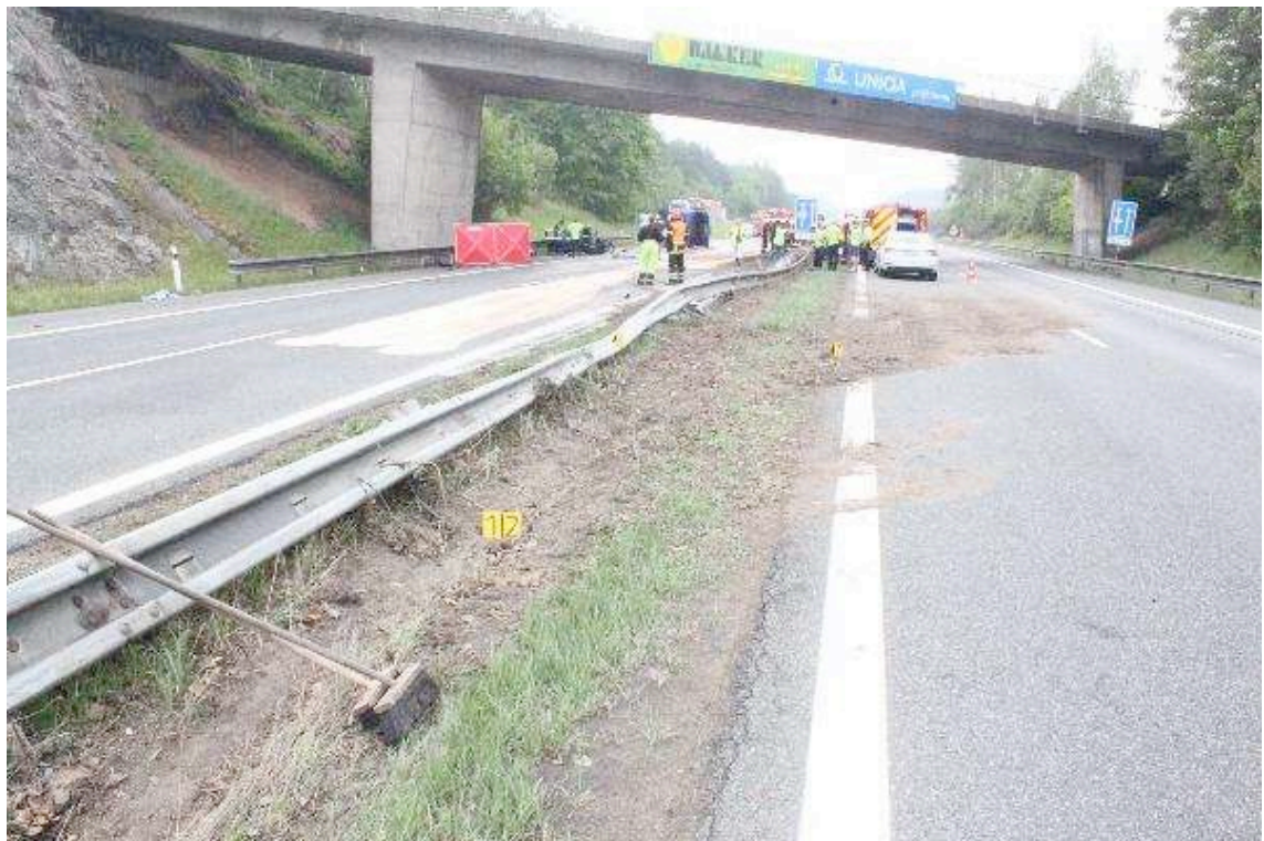
Obrázek 17 Pohled na poškozená středová svodidla, zdroj: vlastní
