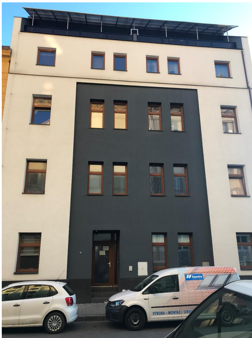
Obrázek č. 13 Dům v Plynární ulici, v soukromém vlastnictví po rekonstrukci
