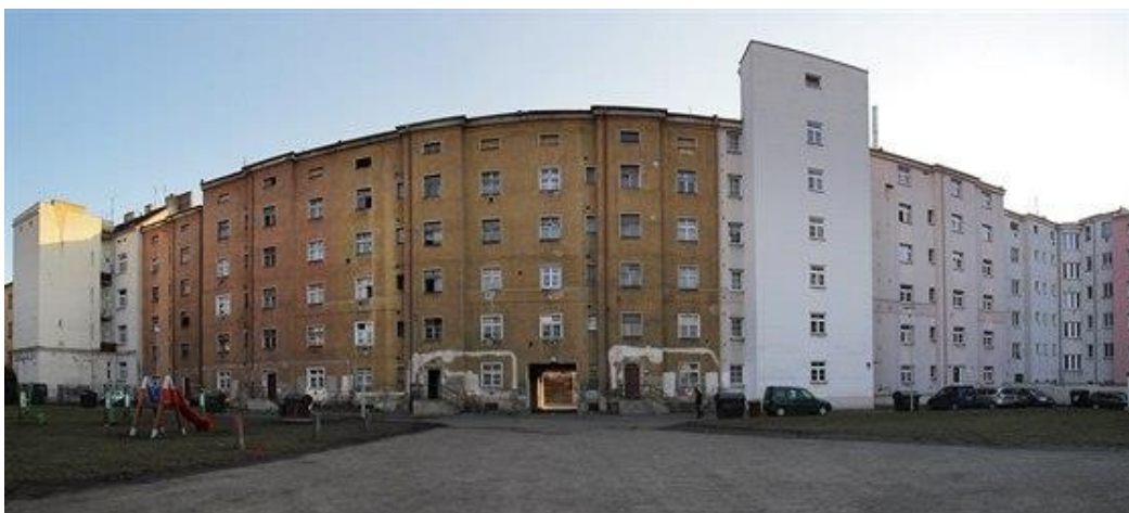
Obrázek č. 9 Vnitroblok domů Plachého před rekonstrukcí
