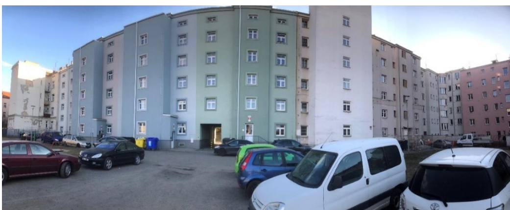
Obrázek č. 10 Vnitroblok domů Plachého po rekonstrukci
