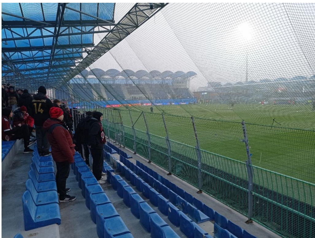
Foto 8 - sektor hostů opatřený sítí a kovovým plotem (Lokotrans Arena)
