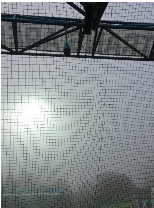
Foto 9 - kamerový systém na střeše tribuny (Lokotrans Arena)
