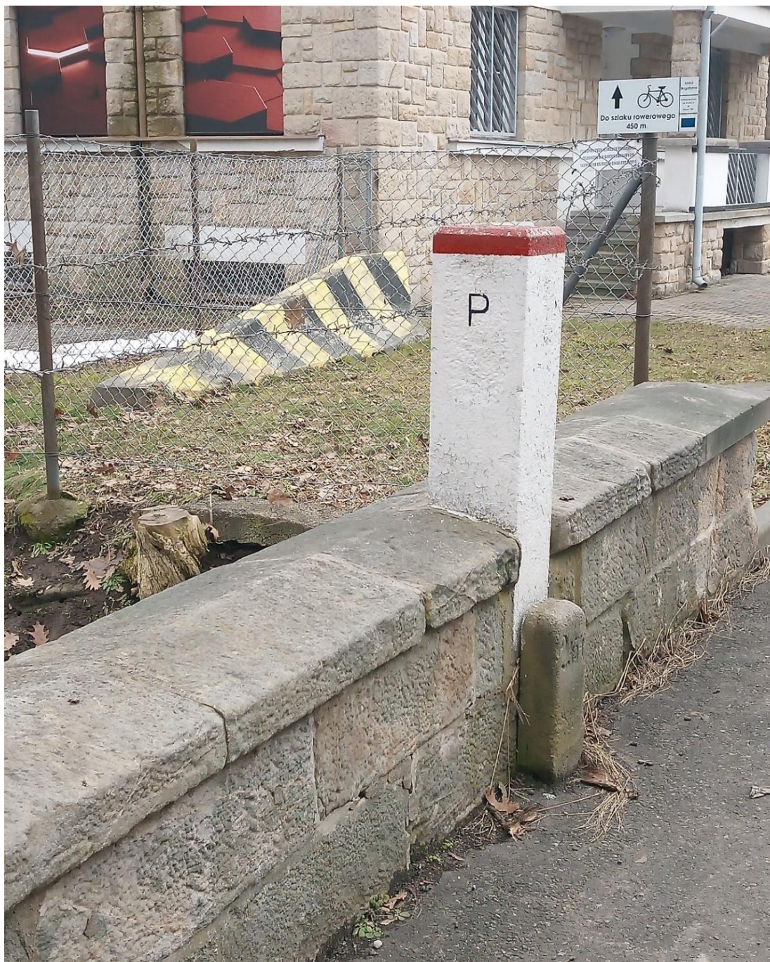
Obr. 1: Hraniční mezník na mostě přes Oldřichovský potok u Hrádku nad Nisou 91
