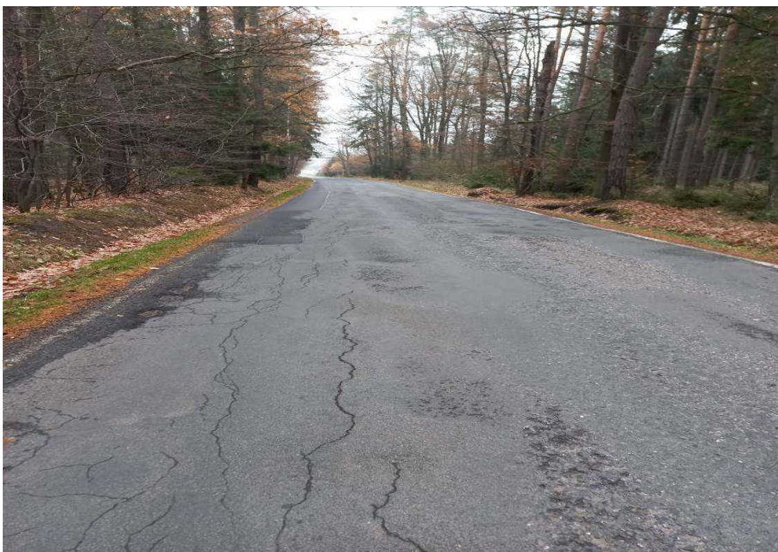
Obr.č.1: Komunikace před frézováním 57
