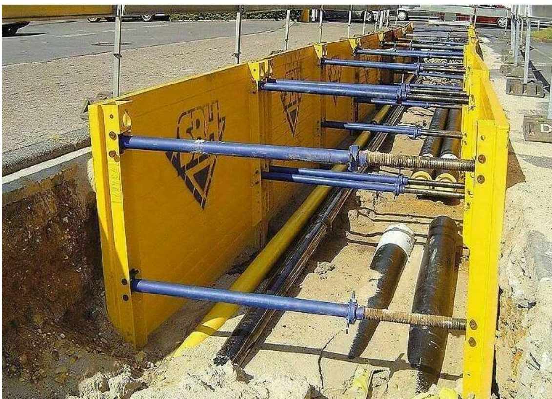
Obr.3: Pažící boxy 59
