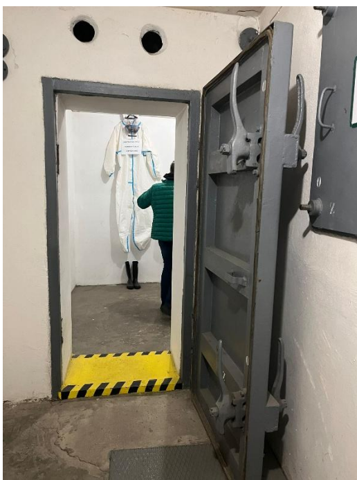
Pohled na protiplynové a protitlakové dveře.
