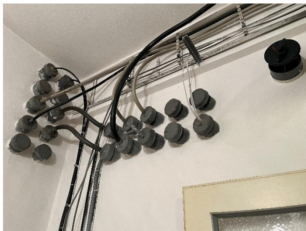
Pohled na těsnění průchodů stěn.
