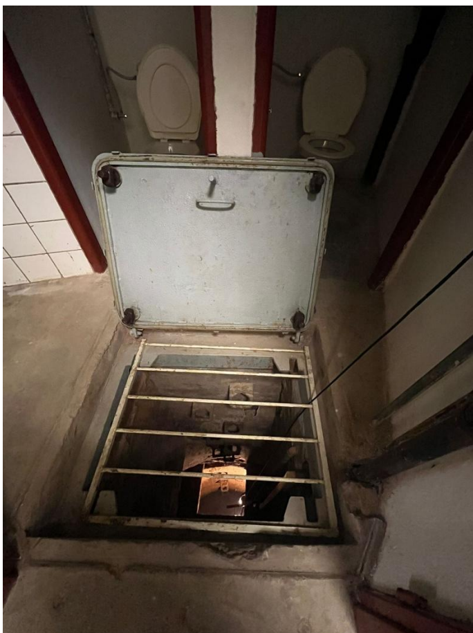
Pohled na vodní hospodářství – kalová jímka.
