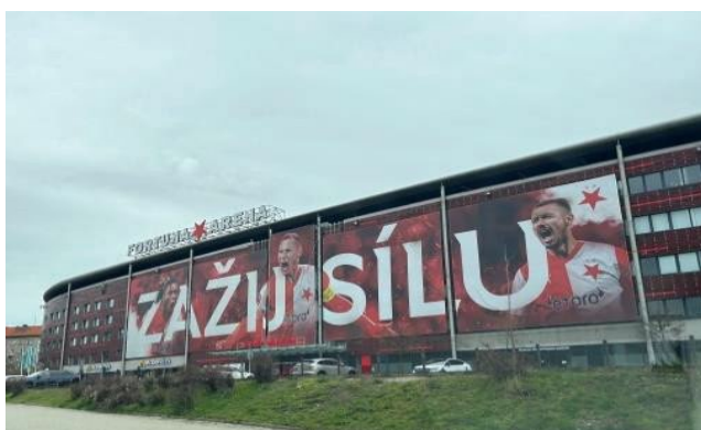
Obrázek 2: Fortuna arena, stadion SK Slavia Praha – vlastní zdroj
