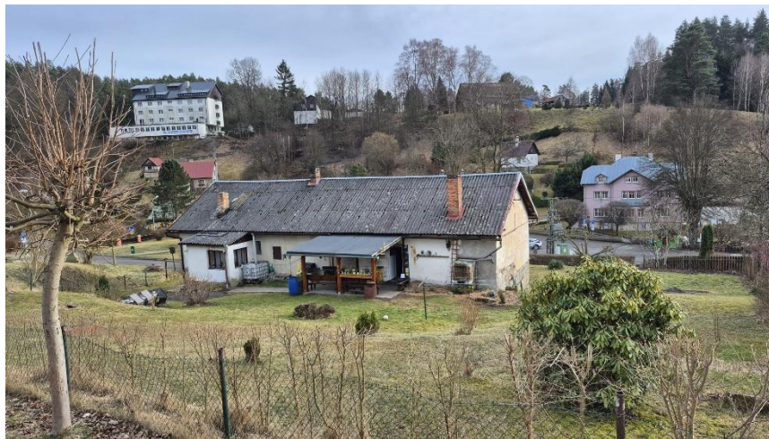
Obrázek 6 - Rodinný dům s azbestovou střechou, zdroj: vlastní
