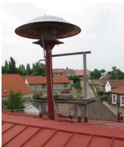
Obrázek č. 1- Elektromechanická rotační siréna 16
