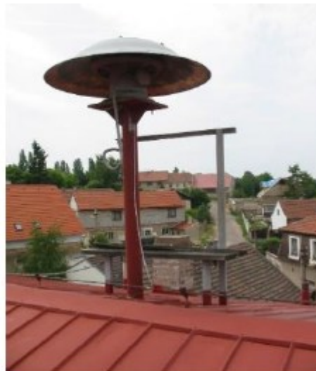
Obr. 5 Elektromechanická (rotační) siréna 41
