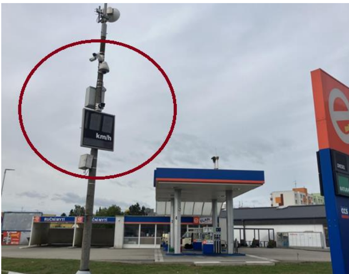
Obrázek 17: Informativní radar se statistickým záznamem – silnice I/3 (ulice Nová) u čerpací stanice ELAN společně s kamerovým bodem městského kamerového dohlížecího systému 96
